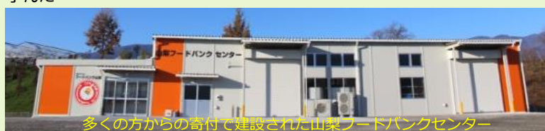
多くの方からの寄付で建設された山梨フードバンクセンター
